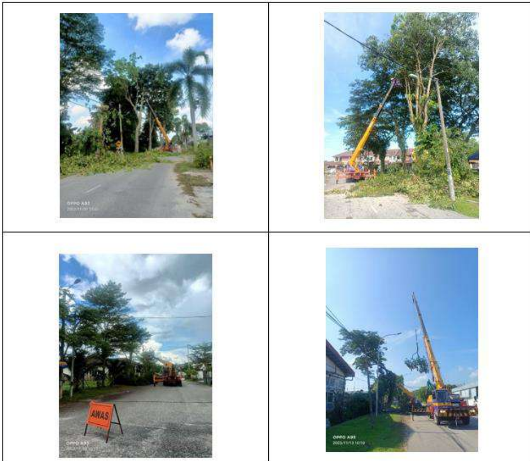
Kerja - Kerja Selenggara / Pelupusan Pokok / Aduan Awam Dan Kerja - Kerja Berkaitan Di Taman Gembira, Taman Puteri Indah, Kawasan Industri Tongkang Pechah, Kawasan Pentadbiran Majlis Perbandaran Batu Pahat Serta Kawasan Sekitarnya
